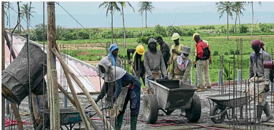
Mühsam errichteten die Arbeiter die Betondecke für das Mädcheninternat, dessen Bau die Togo-Hilfe mit 90 000 Euro unterstützt. Fotos: Stefan Raetz
